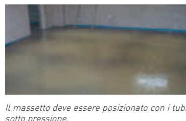
Il sistema di riscaldamento a pavimento non deve essere usato per riscaldare il massetto in cemento.
