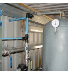
5. Livraison du chantier en un temps record
