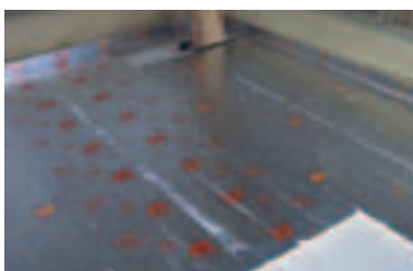
Il pavimento è pulito e libero da polvere e detriti e l'isolante è posizionato sull'area interessata.
