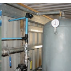
5. Livraison du chantier en un temps record
